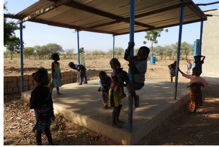
Le préau qui a été dallé
