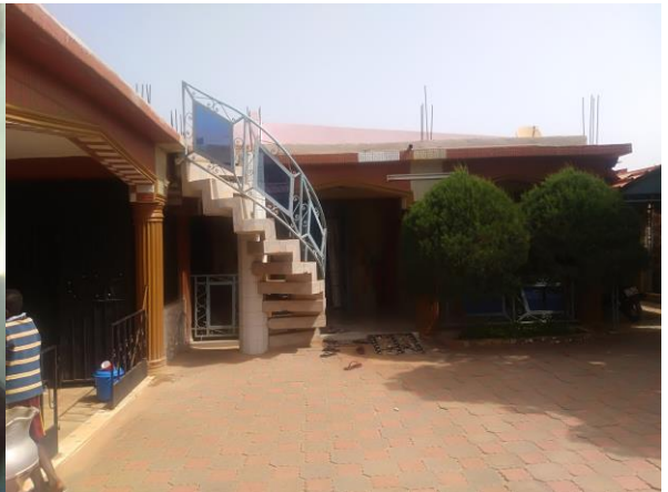
La cour et au fond l'habitation
