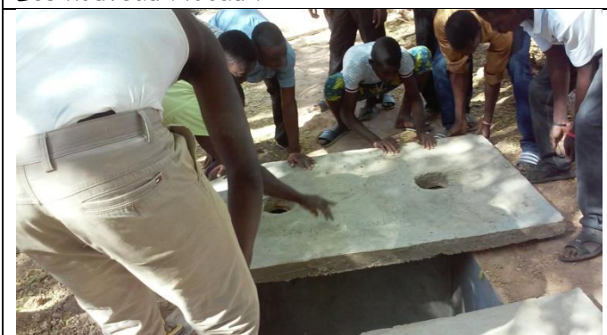
Construction des latrines
